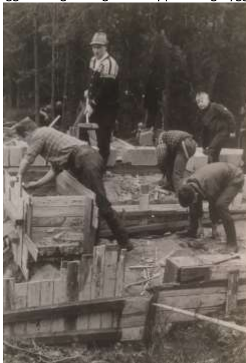
Bilde 154: Forskaling for grunnmuren. Foto: Terje Sørhaug
